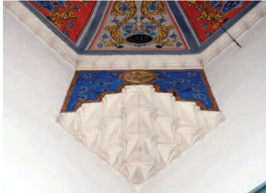
Stalaktitska dekoracija koja se postepeno širi i ispunjava uglove ispod trompi, koje su u donjem dijelu oivičene stalaktitima
