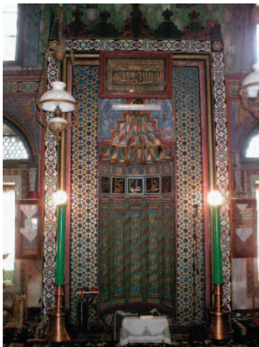
Izgled dekoracije mihraba prije restauracije
