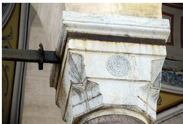
Kapitel stubova na trijemu sa stalaktitskim ukrasom i uklesanom rozetom sa laticama
