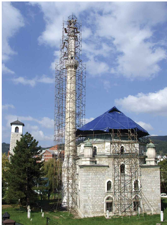
Husein pašina džamija prilikom sanacije 2006. godine
