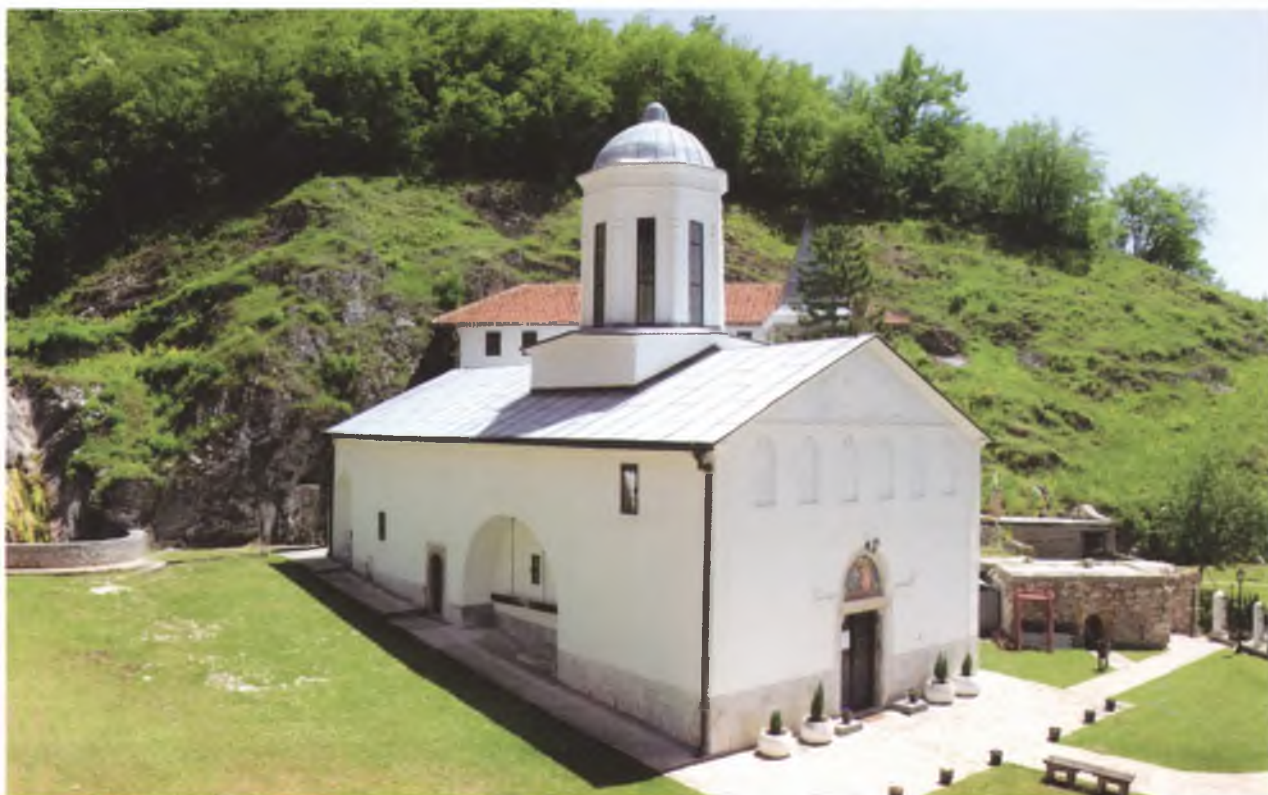
4. Изглед цркве Свете Тројице са северозапада
